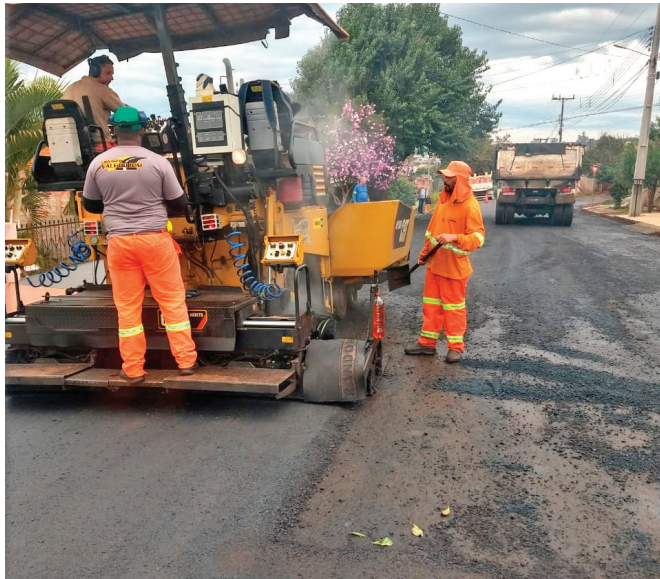
Maquinários trabalham no recape asfáltico
